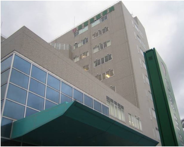
2008年3月にオープンした新病院の外観
