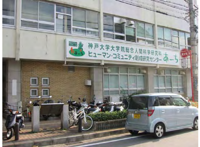
写真 5 - 1 「あーち」の外観
